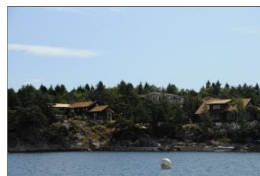
STORSTILT UTBYGGING: Over 500 hytter i Porsgrunn og Bamble har fått eller er i ferd med å få tilgang til vann og avløpsnett. Enkelte har valgt å erstatte den gamle hytten med en helt ny etter at de nye fasilitetene kom på plass. Foto: Per B. Johansen
