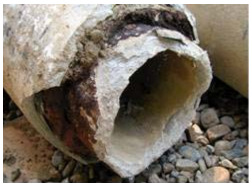
Tubería de fibrocemento
