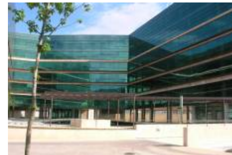
EDIFICIO TRIANON 18.658 m2 s/r
