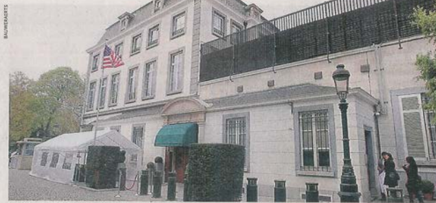
La résidence de l'ambassadeur des États-Unis, rue Zinner, construite il y a 230 ans, s'étend sur 1.496 mètres carrés.
